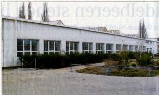
Die neue Halle der Seleon GmbH ist 1 800 Quadratmeter. Das kleine Unternehmen ist seit Jahren auf Expansionskurs.
